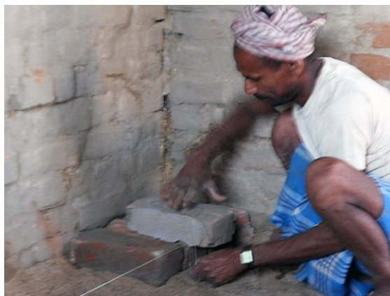
Pose de briques au sol.
