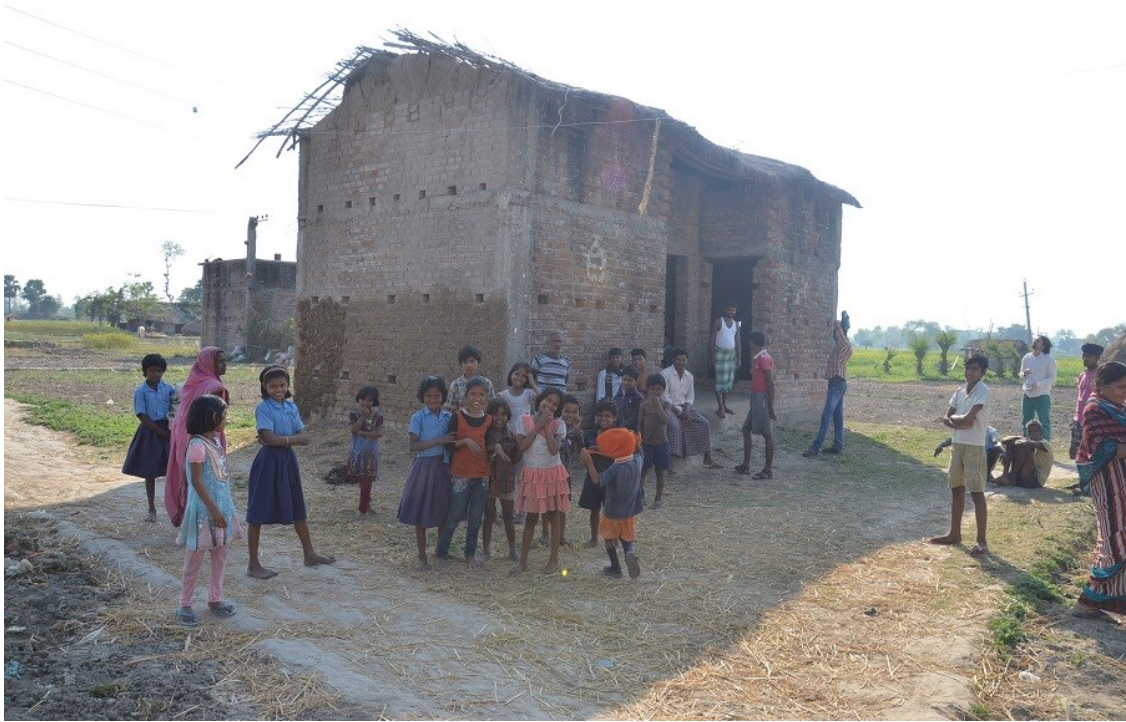
Bâtiment avant les travaux
